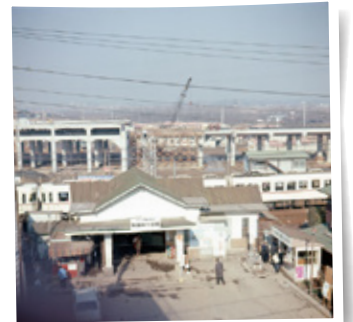
4 昭和44年1月推定 聖蹟桜ヶ丘駅の高架化工事
